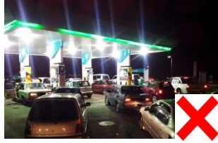
Kamaşma Kontrolsüz Armatürler
